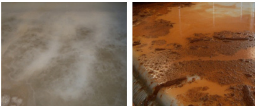
Figur 3-4 Flotationsbassäng med "white water" (t.v.) och hydraulisk slamdekantering (t.h.). Foto: Mia Bondelind.
