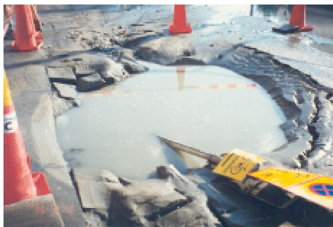
Figur 3-5 Uppschaktat rörbrott i Göteborg med övertryck kvar samt läckande ledning vid Järntorget i Göteborg. Foto: Annika Malm (t.v.), Göteborg Kretslopp och Vatten (t.h.).
